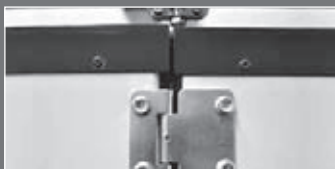
Sřřední pant pružné spojení panelů
